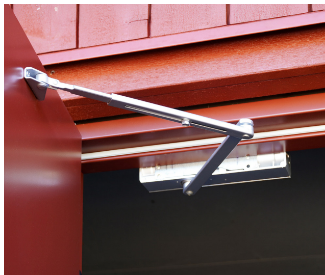
Dörrstängare med standardarm monterad på anslagsida.
