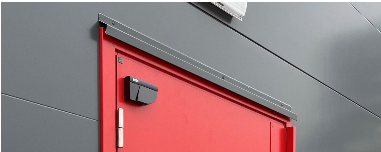
Säkerhetssensor typ flatscan monterad på gångjärnssida.
