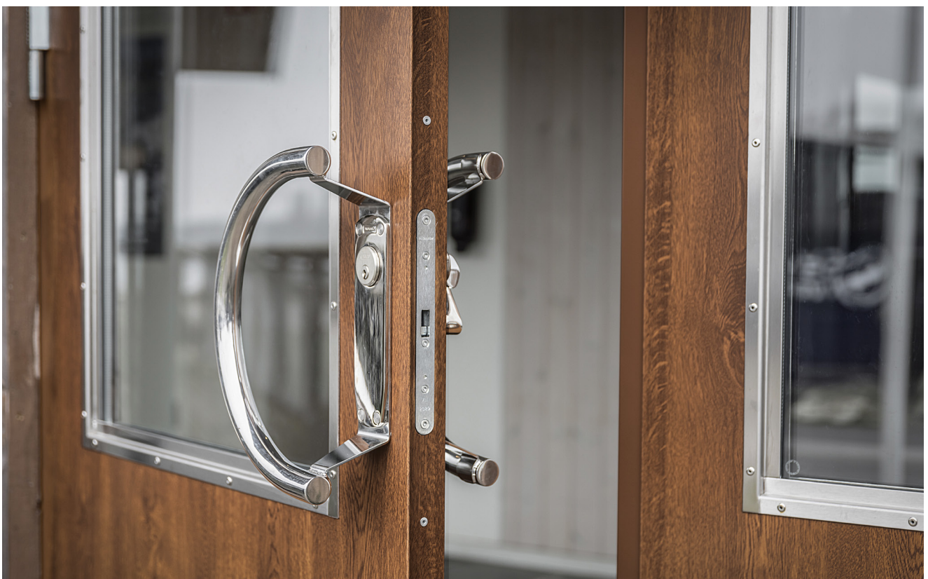
Pardörr med laminat 1061 (mörk ek) och glasurtag GU4 på båda dörrbladen.
