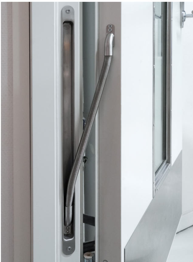
Karmöverföring monterad i karm och dörrblad.
