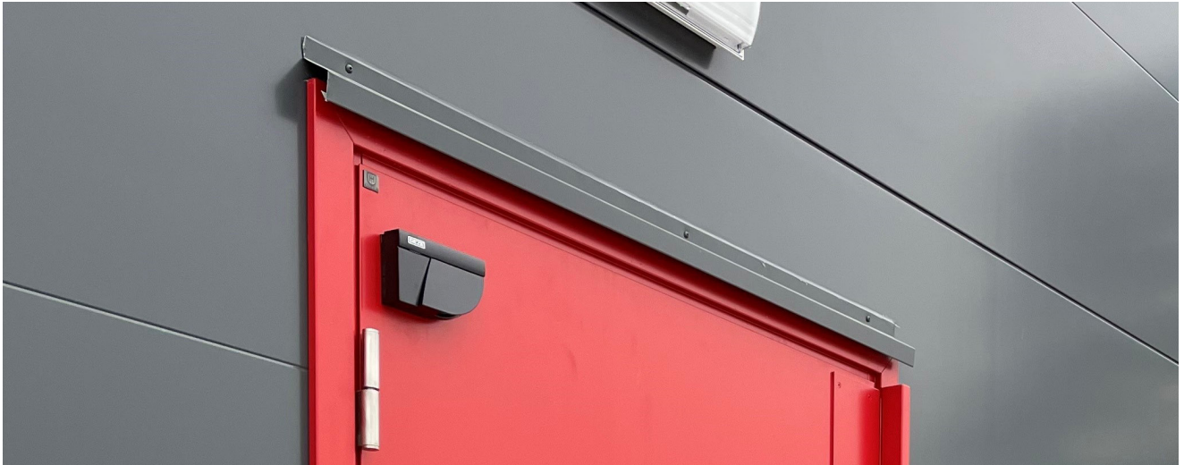
Säkerhetssensor typ flatscan monterad på gångjärnssida.
