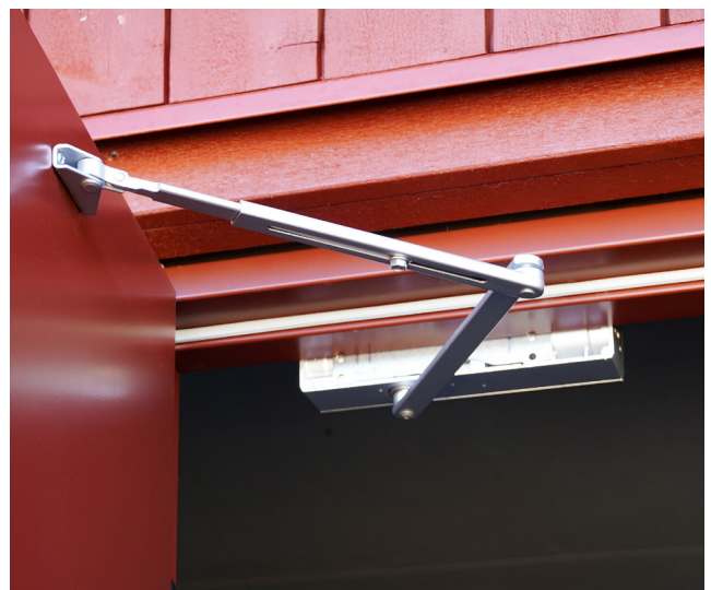
Dörrstängare med standardarm monterad på anslagssida.
